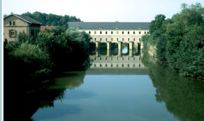
L'un des deux ponts-écluse à six arches en anse de panier conçu par Cormontaigne, quasiment achevé à sa mort en 1752
